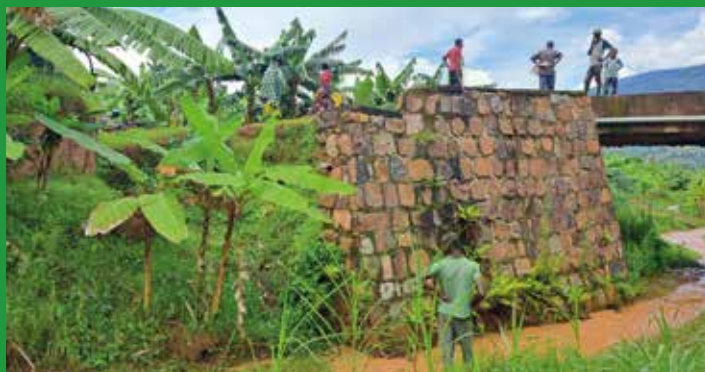
Reconstrucción del puente Zubia berreraikitzea
